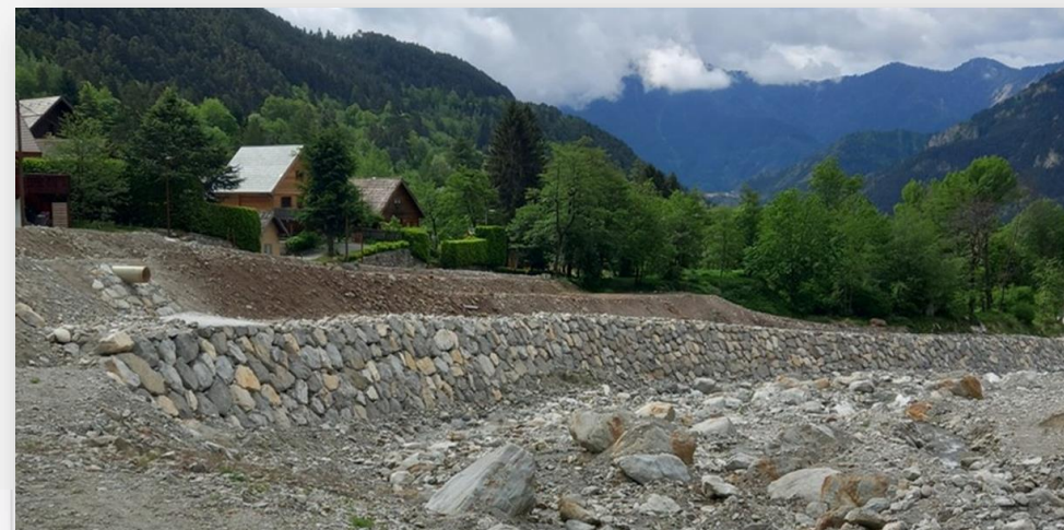
Rive gauche du Boréon – Aval du pont Maïssa
